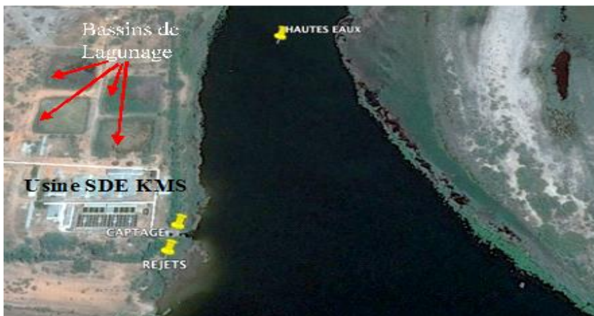
Fig2 : Vue aérienne de l'envahissement de la prise de captage et des bassins de lagunage des boues à KMS
