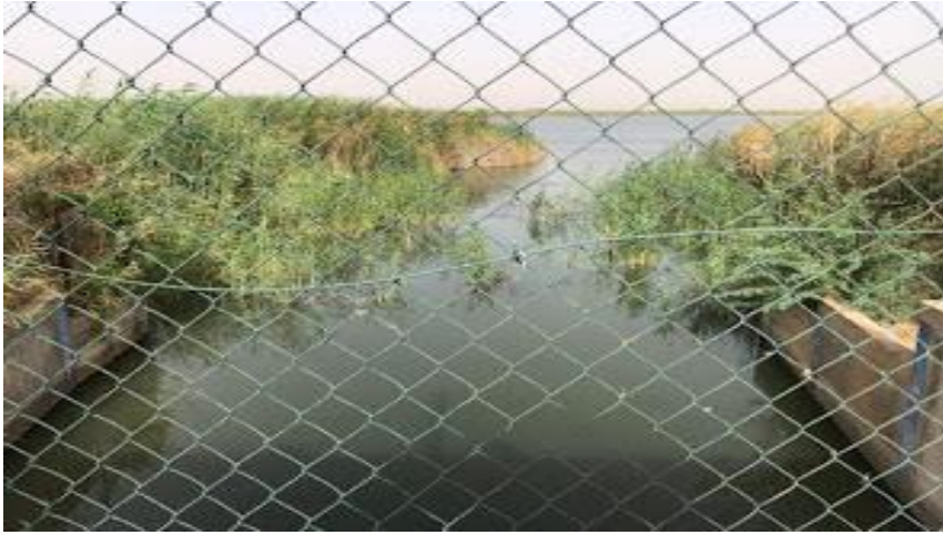
Fig 3 : Vue du canal de prise d'eau de l'usine de KMS
